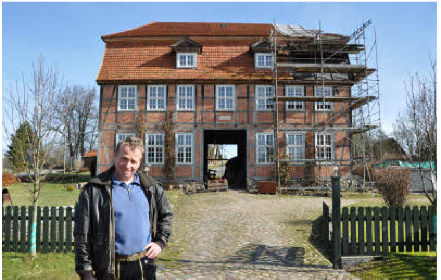
Thomas Stüve hat das Torhaus in Zaschendorf vor dem Verfall gerettet. Noch bleibt aber viel zu tun.
