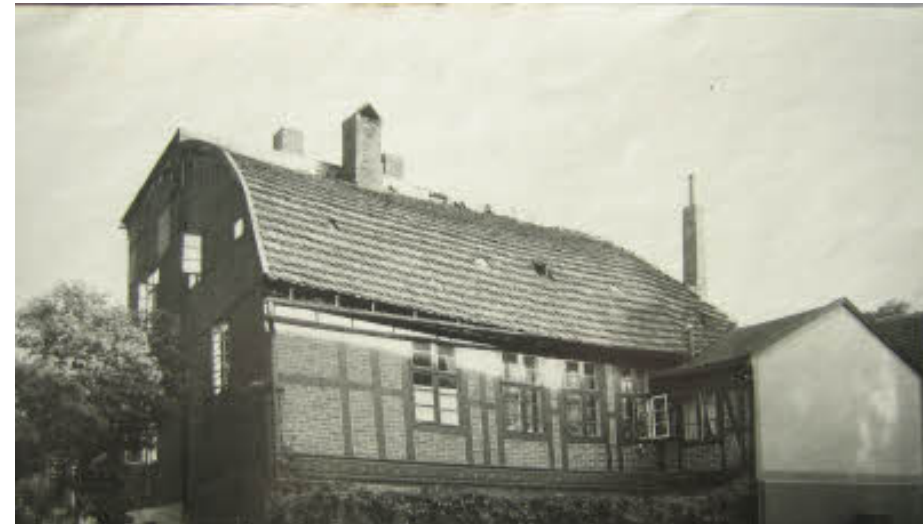
Das ehemalige Haus von Schuhmachermeister Schultz in der Burgstraße 12 FOTO: PRIVAT
